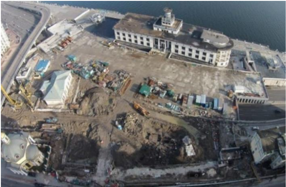
Рис. 2 – Поштова площа під час реконструкції
