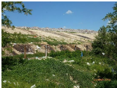
Рис. 4 – Фотографічне зображення району площадки спостережень № 10, на якому темно-коричневим кольором відмічаються місця височування фільтрату з тіла черги «А» полігона № 5
