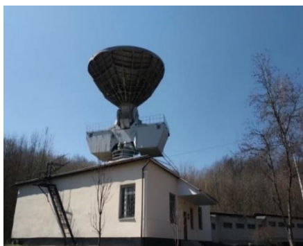
Рис. 1. Зовнішній вигляд станції УНСП-8.2 при сеансі зв'язку з КА «SuperView-1»
